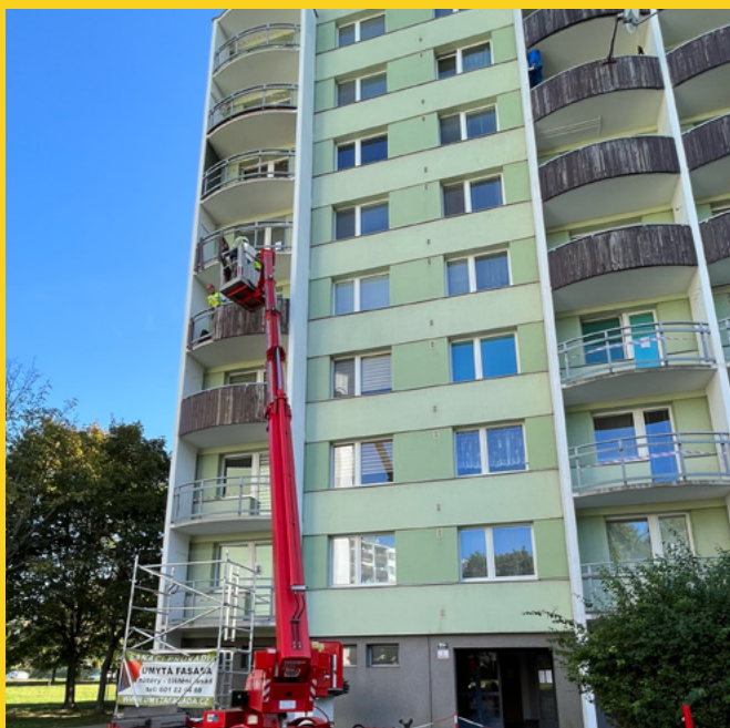
oprava balkonů je velmi rychlá díky pracovní plošině
