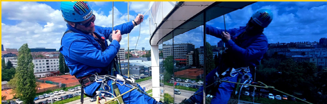
pečlivě čistění skleněné fasády
