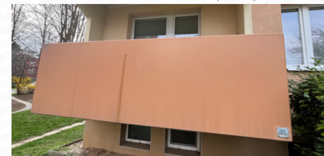
oprava rezivějící části ve stěně balkonu
